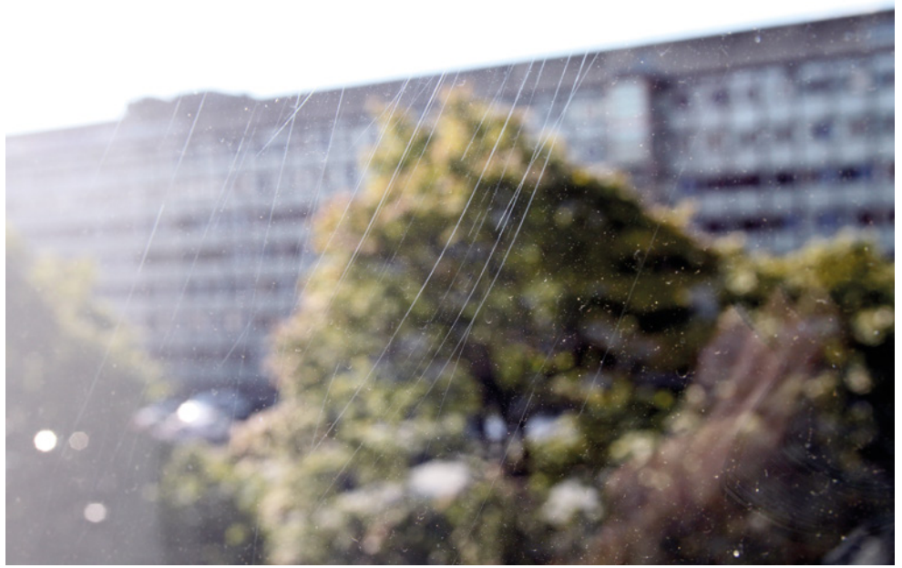
Uvoren bruk av vaskeredskap kan gi riper i glasset. Forholder man seg til Glass og Fasadeforeningens veileder «Tiltak mot overflateskader på bygningsglass – Rengjøring av bygningsglass», unngår man klager og reklamasjoner. Foto: GF
