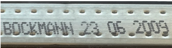
Bilde 1: Bildet av denne avstandslisten viser at vinduet/isolerglasset er produsert 23.6.2009.
