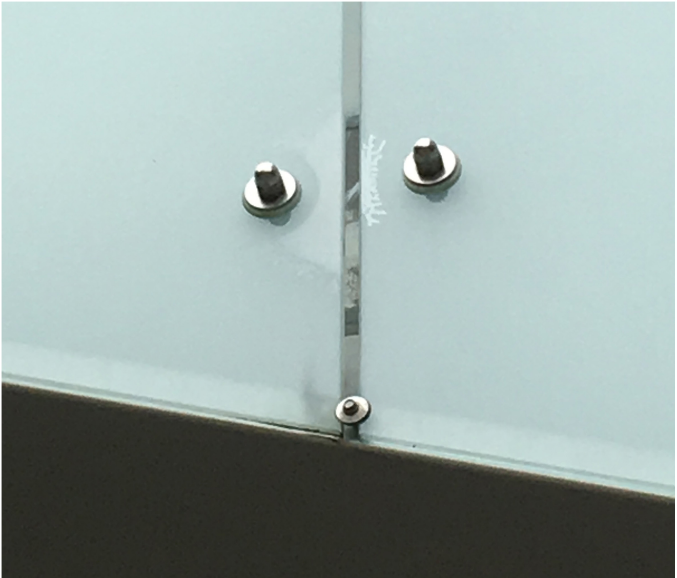
Bilde 4: Delaminering i området rundt punktfastete skyldes ofte feilposisjonering av hull og/eller for hard tilstramming. Se også bilde 2.
