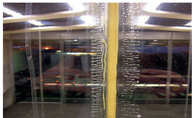
Bilde 5: Eksempel på delaminering som skyldes fugemasse som ikke er kompatibel med laminatfolien i glasset.
